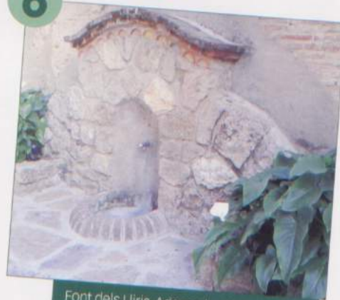
Font dels Liris. Adossada a la paret de la façana de darrere de cal Besoret. Consta d'una pica semicircular envoltada de paret d'obra. La mateixa construcció s'allarga amb un parterre a cada costat on hi ha plantats liris de Sant Josep, que mantenen els veïns. Perfecte estat de conservació.
